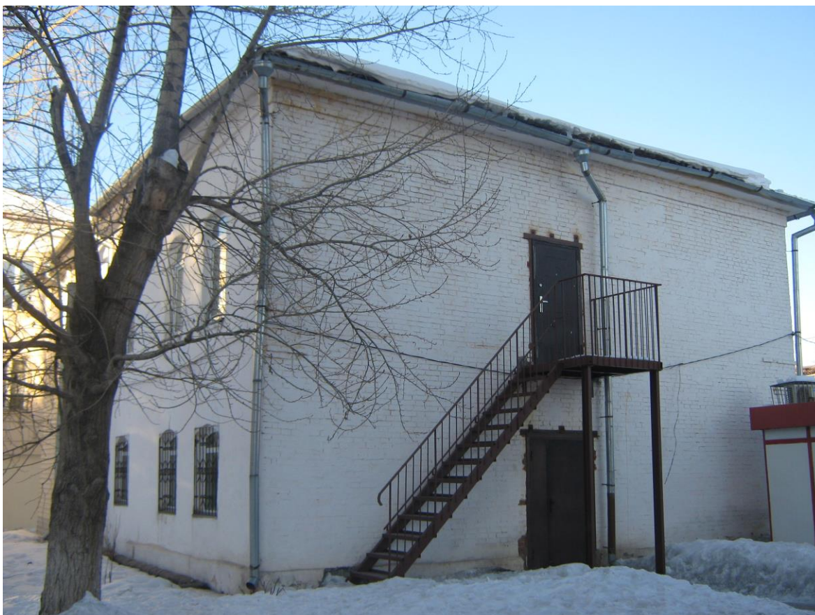
Рис. 9. Детская школа искусств № 2. Восточный фасад здания.
