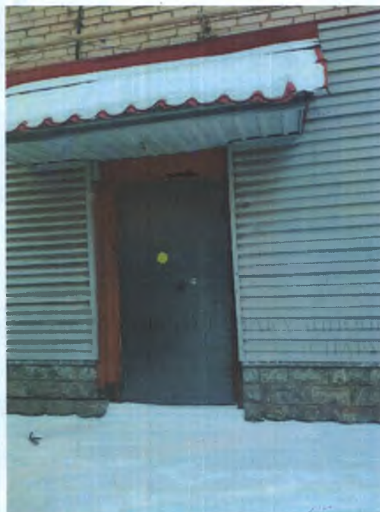
ФОТО № 7 ВЫХОД ЭВАКУАЦИОННЫЙ (СНАРУЖИ)
