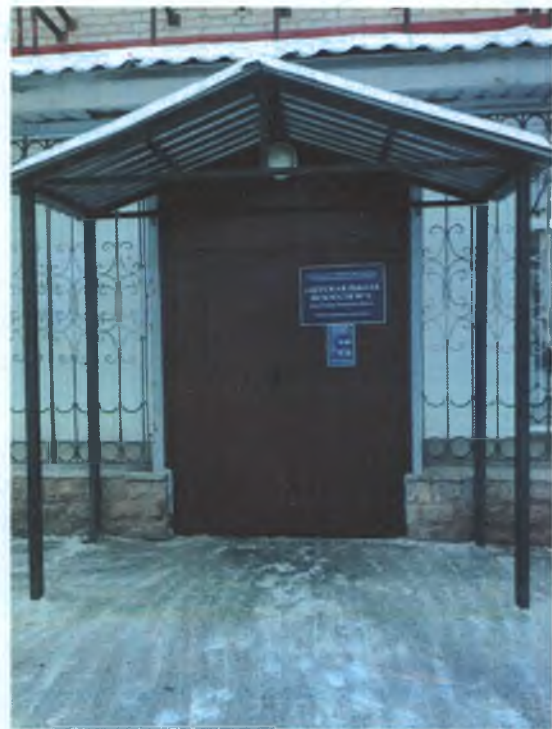
ФОТО № 3 ВХОДНАЯ ЗОНА, ДВЕРЬ
